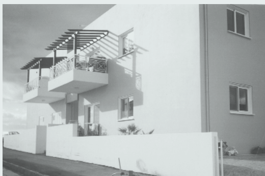
Συγκρότημα κατοικιών, διαμερισμάτων και καταστημάτων Ύψωνας, Λεμεσός
