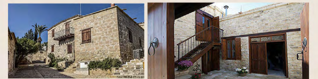
φυσικό έδαφος, χρωματιστό βοτσαλωτό μπετόν, σταθεροποιημένο κεραμικό δάπεδο =, κυβόλιθοι ανά αποστάσεις σε συνδυασμό με χάρμα/φύτευση
